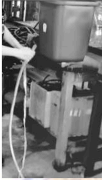
Gambar 3. Proses pemasangan selang air pada tandon air
